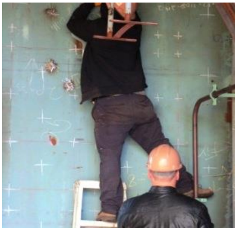
Improper use of a stepladder.
