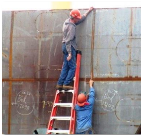
Improper use of a stepladder.
